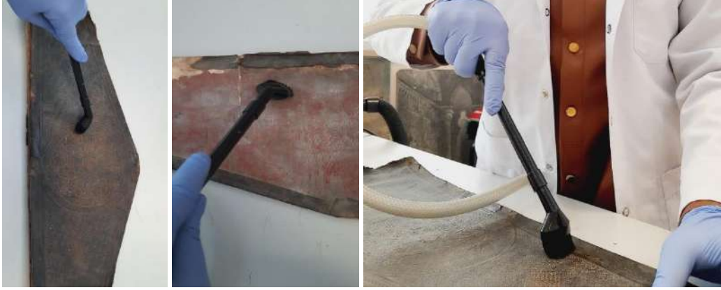
Resim 17-18-19. HEPA filtreli ayarlanabilir vakum cihazı ile yapılan temizlik uygulamaları
